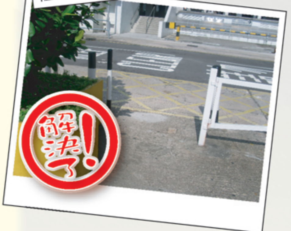
大環山公園通道設有鐵柱，阻礙輪椅人士出入
