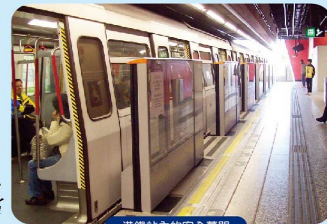
港鐵站內的安全幕門
